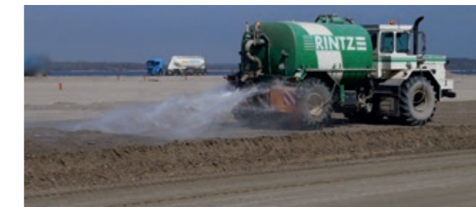
7. Nachwässern des fertigen Erdplanums
