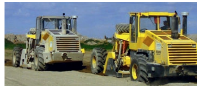
3. Einfräsen des Bindemittels in den Boden (bis zu 50 cm tief), auch mit direkter Wassereinspeisung möglich
