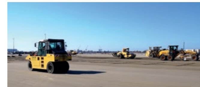
4. Herstellung des Planums mittels Grader, Glattmantelwalze und Gummiradwalze
