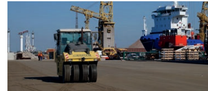
6. Glätten der Kerbstellen
