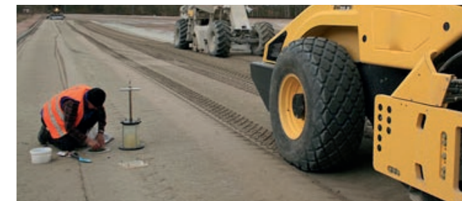
8. Probenbohrung an einer Kerbstelle zum Nachweis des kontrollierten Risses
